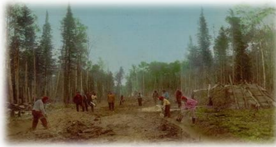
Рисунок 2 – Строительство Суловского тракта.
